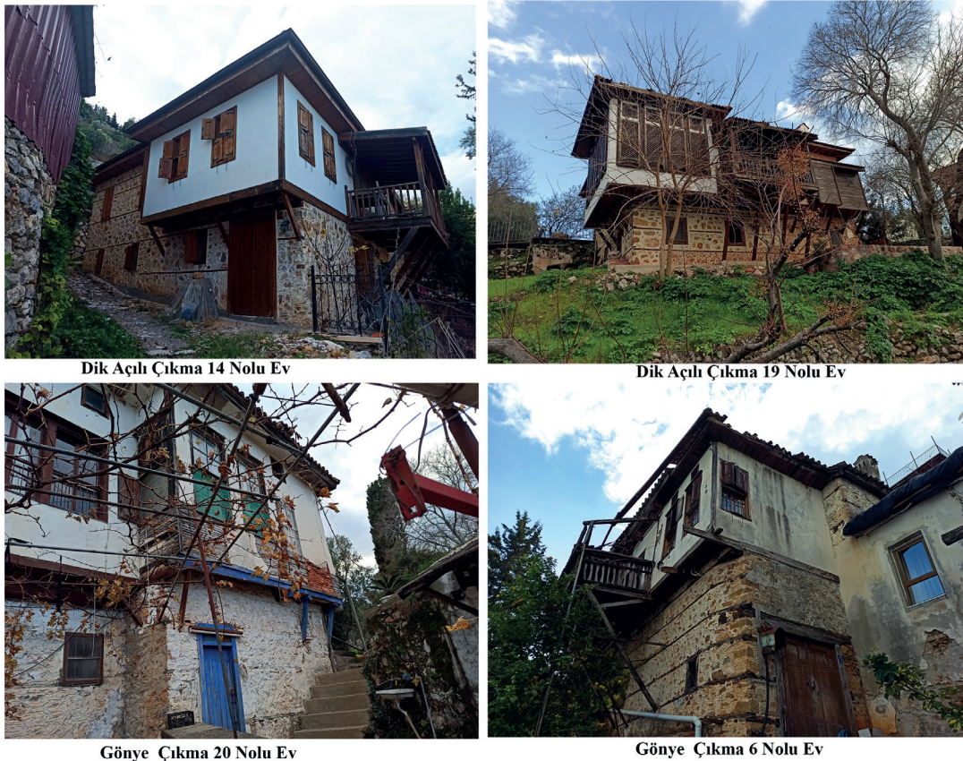
Fotoğraf 6. Biçimine göre çıkma tipleri / Protrusion types according to form (Erkovan, 2022).
