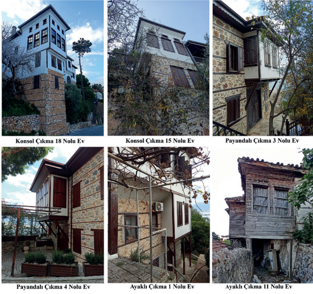
Fotoğraf 5. Yapım tekniklerine göre çıkmalar / Protrusion types according to construction techniques (Erkovan, 2022).
