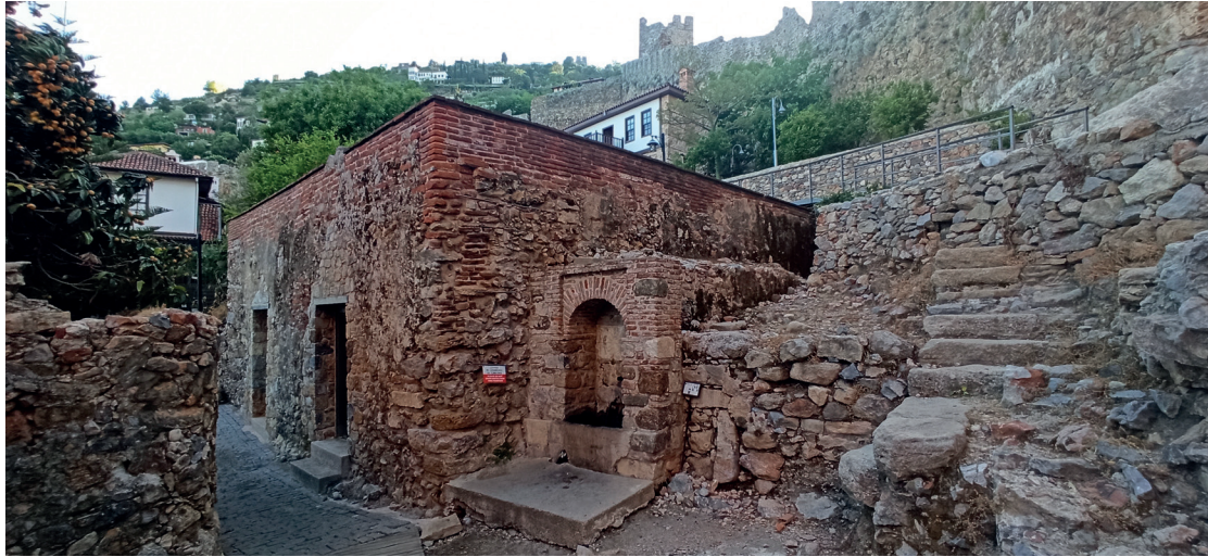
Fotoğraf 2. Alanya surları yerleşmesi, çeşmeli sarnıç / Alanya walled settlement, cistern with fountain (Erkovan, 2022).
